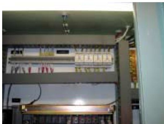
Umístění měřicí sestavy v elektroskříní
